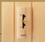
i Управление воздушным потоком свободной тяги можно осуществлять изнутри сауны с помощью деревянной ручки.
