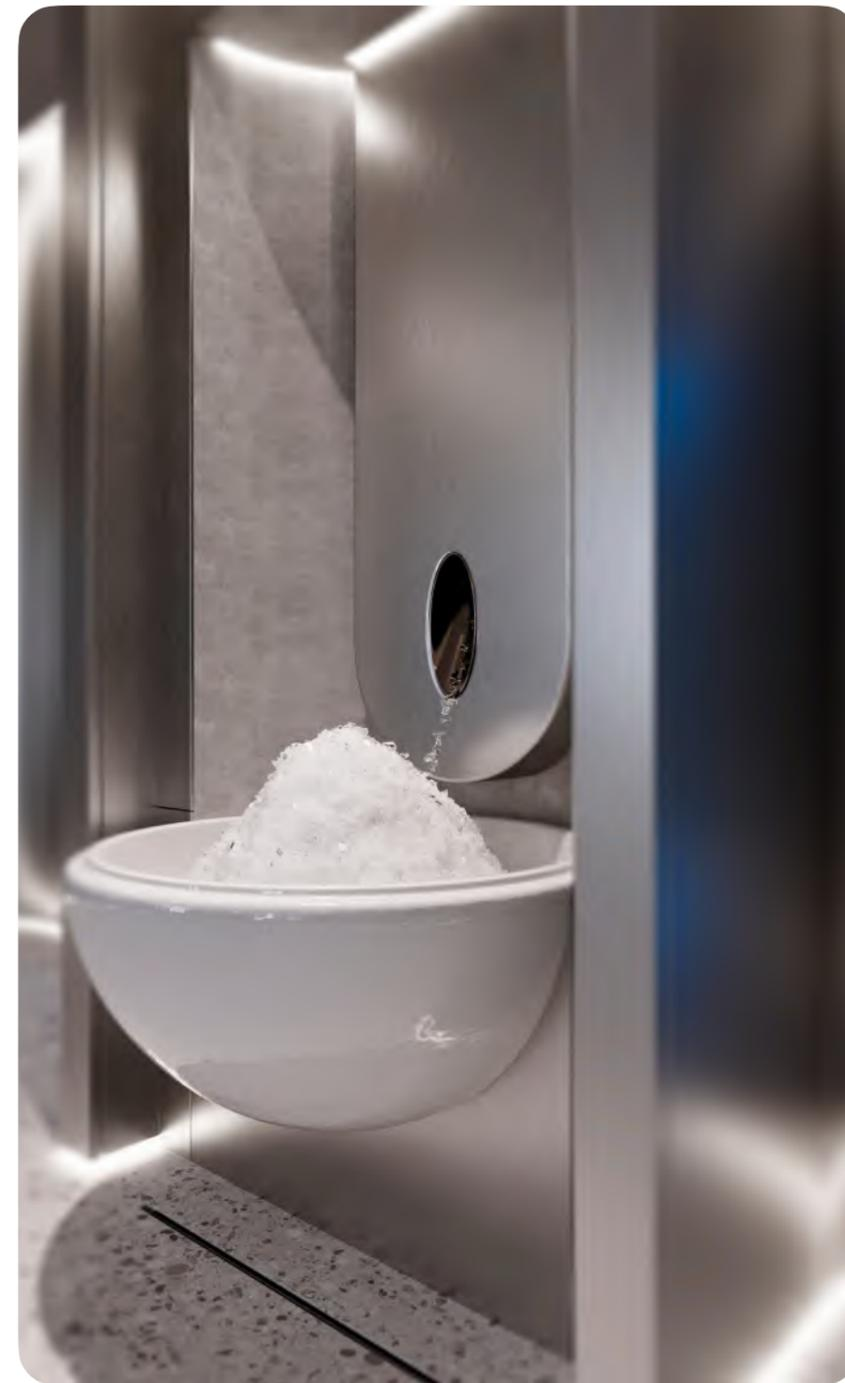
Техническое решение продумано до мельчайших деталей: датчик переполнения чаши льдом интегрирован в потолок в гильзе из нержавеющей стали, элемент выхода льда встроен в стену. Ледогенератор размещен в специальной нише над чашей сбора льда, доступ к нему обеспечивается через скрытый ревизионный люк. Для эффективного отвода талой воды под чашей установлен целевой трап.
